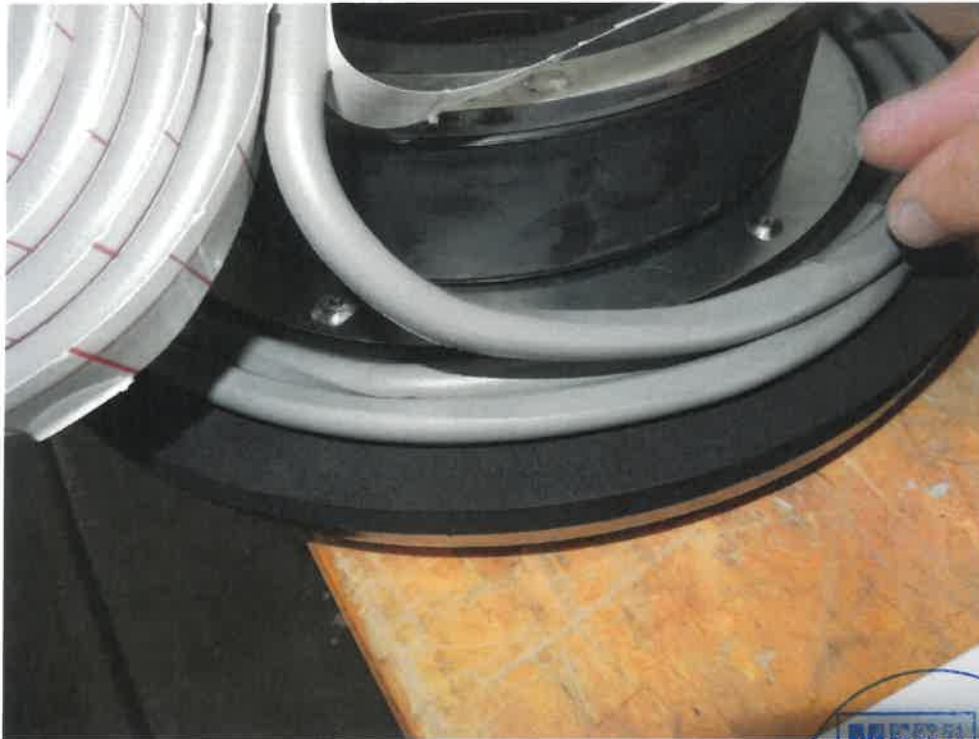
Bild 9: Vorbereitung des Dichtungseinsatzes Curaflex SD DN 200 durch Aufbringen von 3 Reihen Curaflex Butyl-Dichtungsband Type 1753
