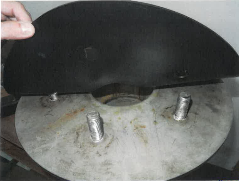
Bild 3: Auflegen der 1. EPDM-Zulage auf den Festflansch
