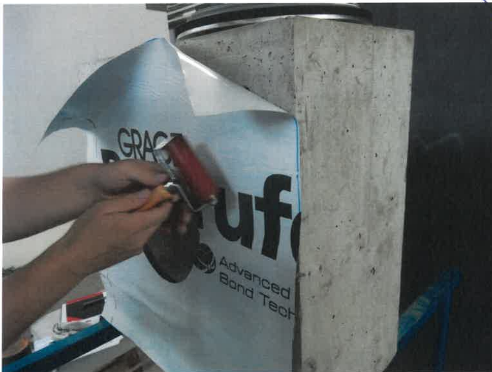
Bild 8: Anbringen der FBVB Preprufe ® 800PA vor dem Einbau des Dichtungseinsatzes
