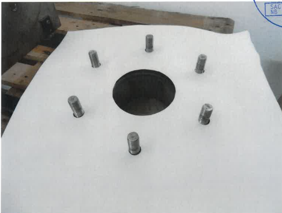
Bild 4: Einbau der Frischbetonverbundbahn Preprufe ® 160R
