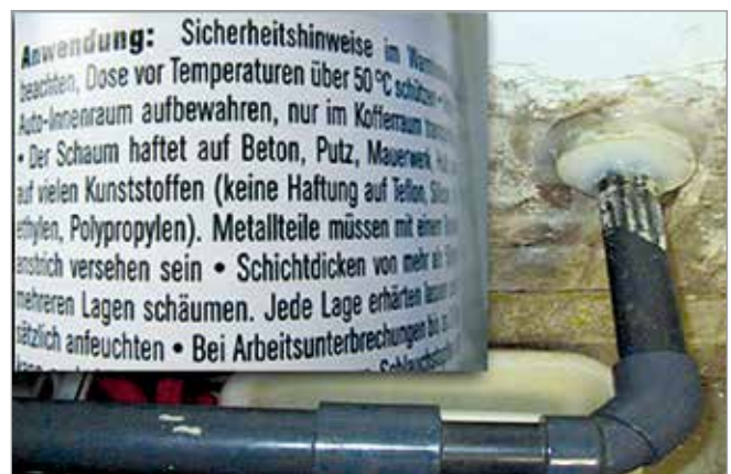
③ Wasserdurchlässige Dichtungsmaterialien bzw. fehlende Adhäsion (Beispiel 2)
