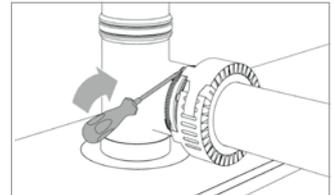
Spannschelle um die Haltetaschen legen und damit Manschette am Gussrohr befestigen.
